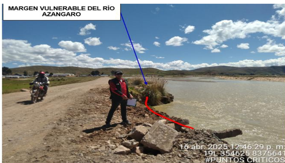
FIGURA N°02: LA PRINCIPAL VIA EXISTENTE Y PROPENSAS ANTE UNA CRECIDA DEL RÍO CRUCERO Y LA EROSION EN LA MARGEN DERECHA.
